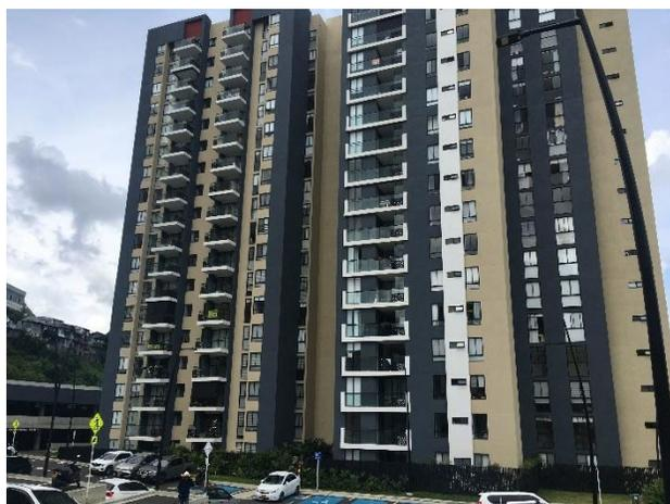
**FOTO 3.** Fachada principal de torre de apartamentos Keirón. Fachada con acabado en pañete y pintura.
