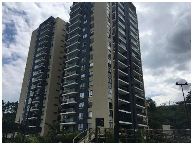
**FOTO 1.** Fachada principal de la torre de apartamentos Anemoi. Fachada con acabado en pañete y pintura. Cada torre de apartamentos fue conformada por 2 unidades estructurales independientes que cuentan con junta de construcción en zona intermedia de cada torre.
